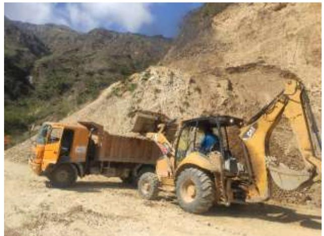
OBRA: Perfilado de talud en la calle Gonzalo Pizarro donde se origino un socavón debido a las fuertes intensidades de lluvia ocasionadas por el invierno.
