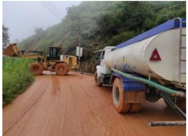
OBRA: Limpieza de derrumbe ubicado en la vía
