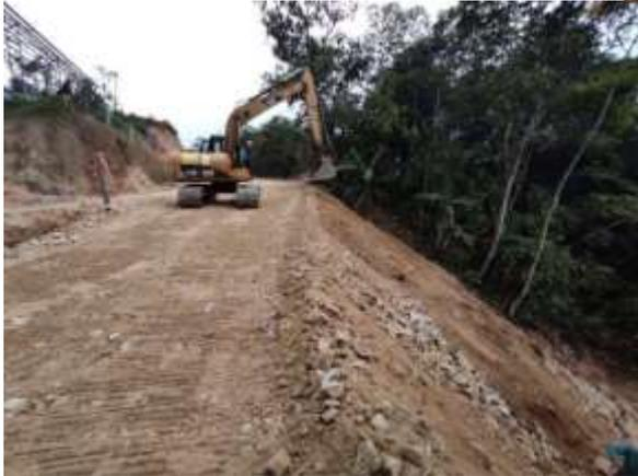
**OBRA:** Excavación de terreno para colocación de tubería en vía el bosque con maquinaria del GADM Zaruma.
