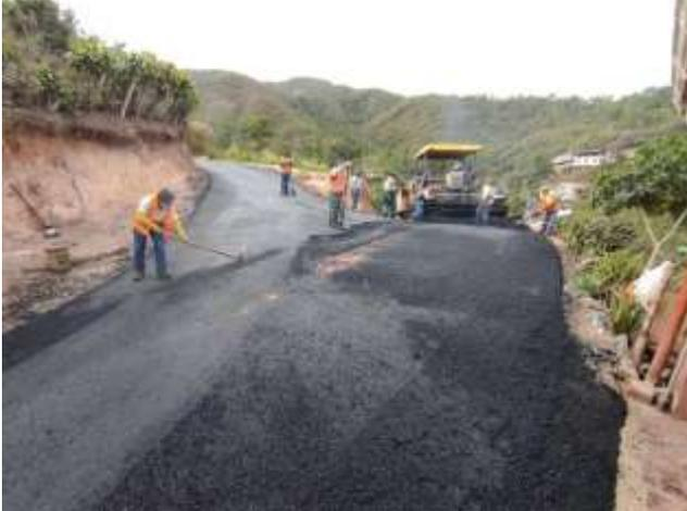
OBRA: Colocación de Subbase tipo II para luego implementar el asfaltado en la parroquia de Muluncay.
